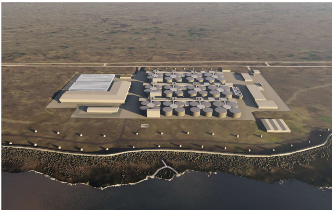
Mynd 10.3 Umfang mannvirkja eldisstöðvar Geo Salmo gefin til kynna í landslagi.
